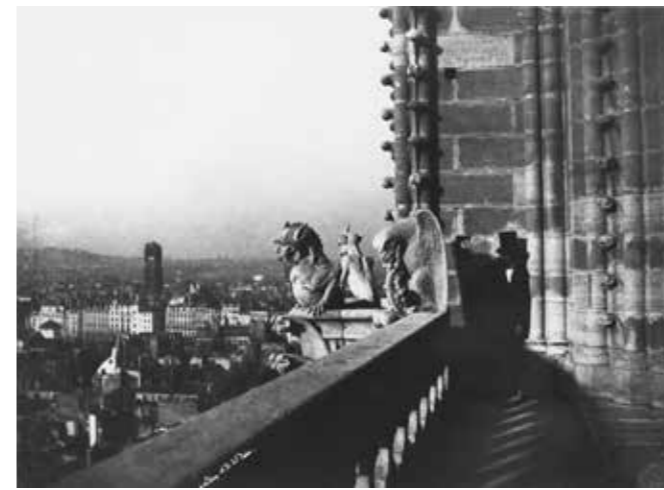
Gargouilles de la tour sud de la cathédrale, Henri Le Secq, photographe, vers 1853. © Médiathèque du Patrimoine et de la Photographie, dist. RMN-GP
