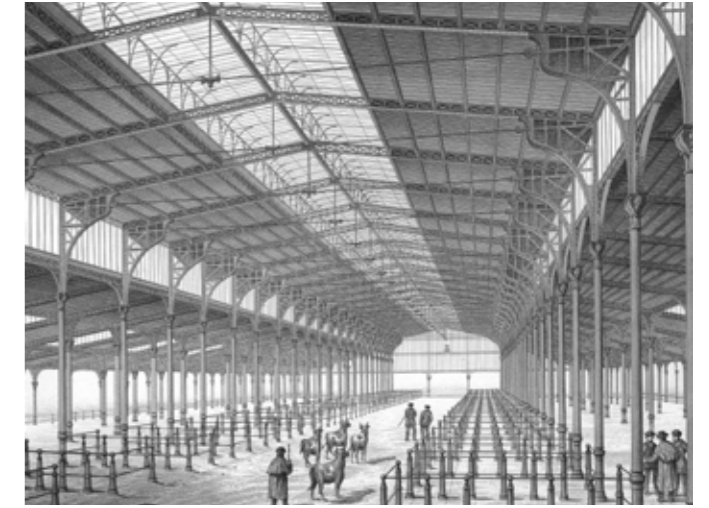
« Abattoirs généraux et marché aux bestiaux. Marché - vue intérieure », Louis-Adolphe Janvier, architecte, in Félix Narjoux, Paris. Monuments élevés par la ville, 1850-1880 , vol. 2 : Édifices d'utilité générale , Paris, Morel, 1883. © Ville de Paris/BHVP
